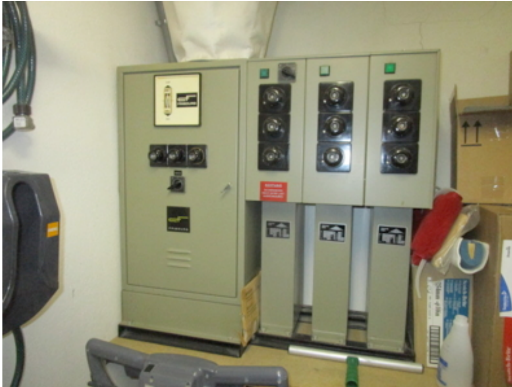
Abbildung: Blindstromkompensation
