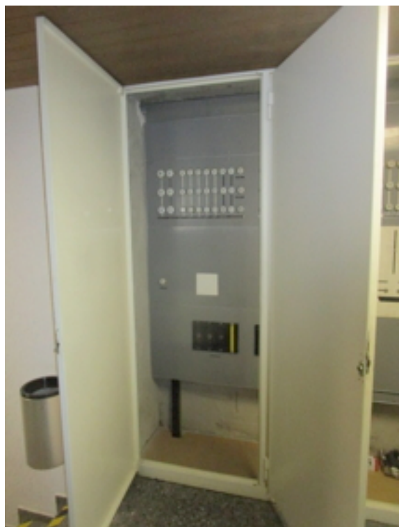
Abbildung 2: Hauptverteilung Elektro
