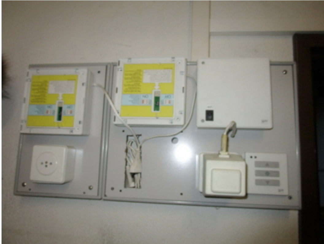
Abbildung: Dachfenstersteuerungen
