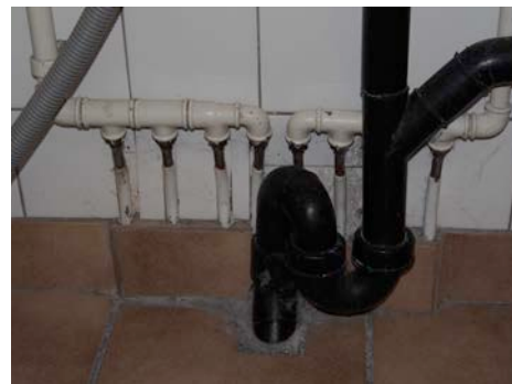
Alte Kupferleitungen im Boden eingelegt
