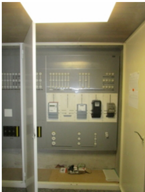
Abbildung 1: Hauptverteilung Elektro
