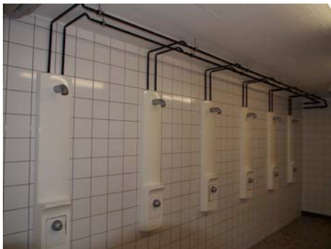
Schwimmbad Duschraum. Sanierte Leitungen nach Rohrbruch.
