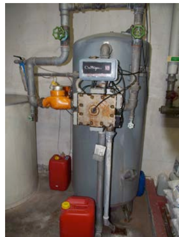
Enthärtungsanlage
