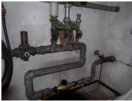
Wasserzuleitung in Technikzentrale
