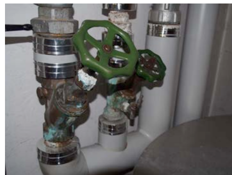
Kalk und Grünspan an Armaturen
