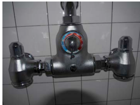
„Kuglostat“ Warmwassermischer für Schwimmbadduschraum.
